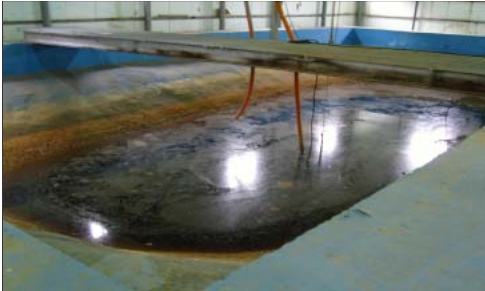
【용암환경자원사업소 침출수 현장】
