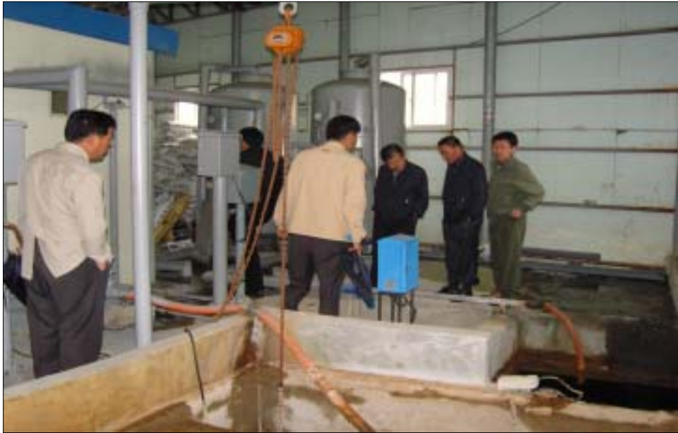
【용암환경자원사업소 침출수 현장】
