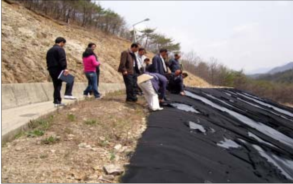
【내속리면 갈목리 갈목매립장 현장】
